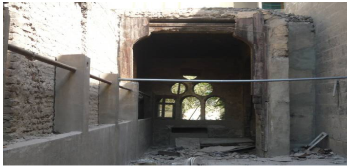
صورة (3): توضح إلقاء القمامة على سطح المدرسة
