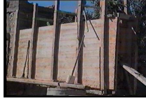
إقامة الجدران بواسطة القواب
