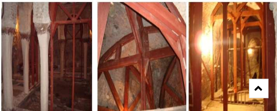
Figure 6 : Travaux d'urgence avec mise en place des étaitements
