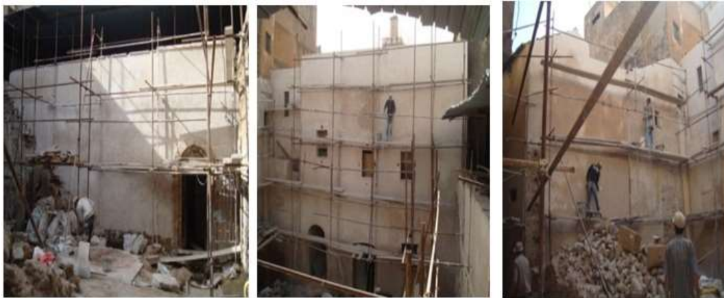
Figure 7 : Travaux de ravalement de façades
