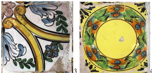
3 : Abrasion/ Erosion + Consommation. 4: Ecaillage ou escoussage ou écoussage.
