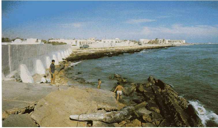
Figure 6 : L'hôtel d'Eljazeera était proche de la mer dans les années 1950 à Djerba, il a perdu sa plage sous l'effet de l'érosion marine. Cet hôtel a reculé en détruisant une partie des chambres proches de la mer (1991)
