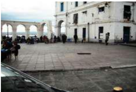
Figure 127: Place Hadj Mrezek Avant Intervention. Source: Auteur.
