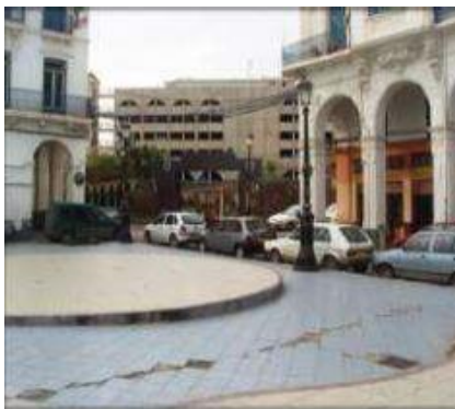
Figure 130 source: auteur. : place l'Amirauté avant intervention
