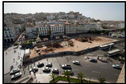
Figure 76: vue sur la place 8 Mai .
