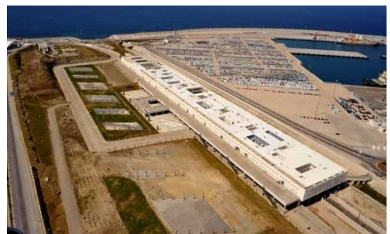
Figure 95: La modernisation de la gare maritime.
