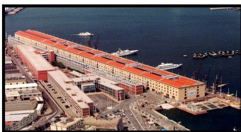
Figure 113:I.1. Les entrepôts de coton réhabilités
