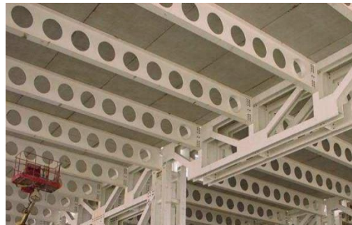
Figure 160: des poutres métalliques alvéolaires. Source: mémoire master
