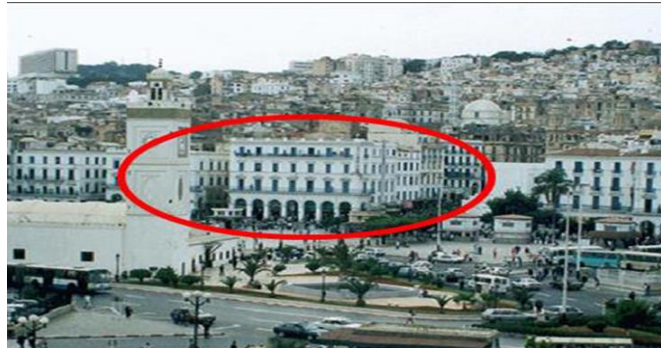
Figure 36: Les façades de l'environnement batit du quartier de la marine
