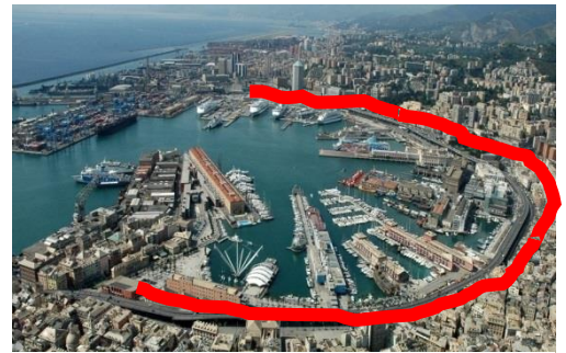
Figure 105 : la rupture entre le centre historique et le port à cause de la route à grande circulation. Source : gène le renouvellement d'une ancienne ville marinière
