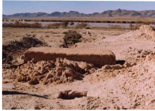
Photo n° 25.-Travaux de rénovation du puit de Oglat ed Daira avec bache d'eau en très mauvais état(1.12.2003).
