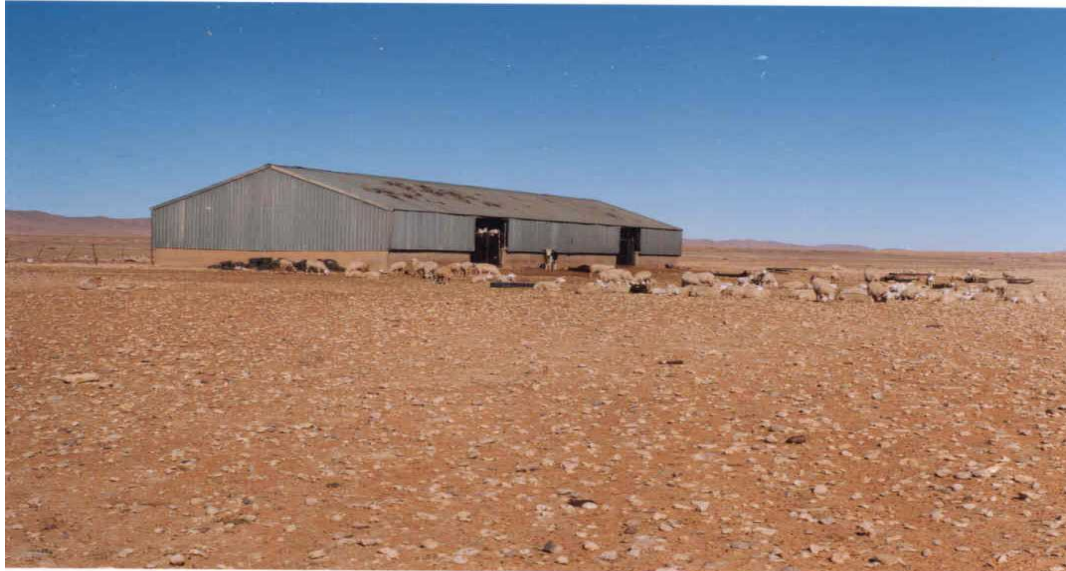
Photo n°2. – Hangar servant comme bergerie à El Mesdouria.
