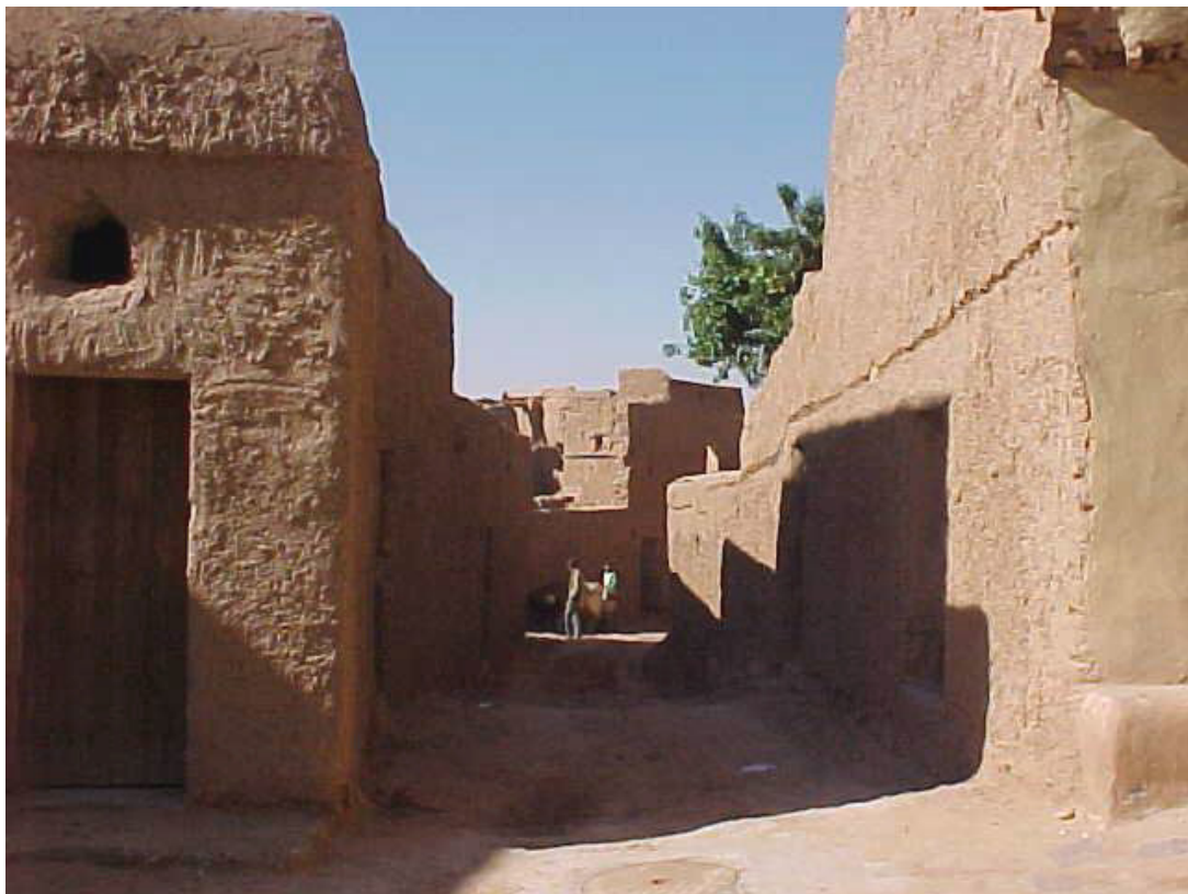
Fig. 15 : Darb (rue centrale) Ikhrazam à Boussemgoun (2003)
