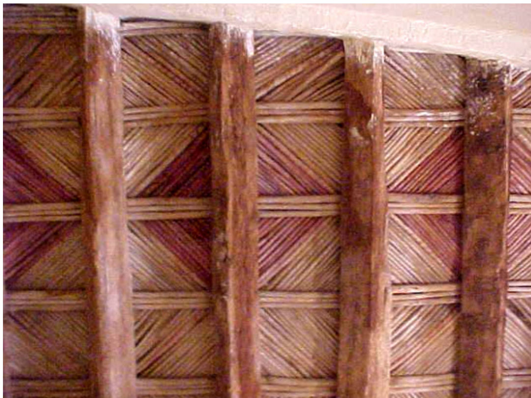
Fig. 36 : Lattis serré de tiges de roseau à Boussemgoun (2003)
